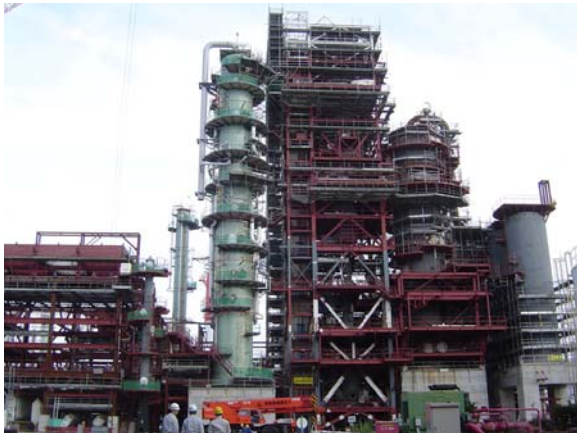
建設中の第2FCC装置
