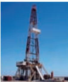
サウス・ゼイト・ベイ 鉱区の試掘現場
