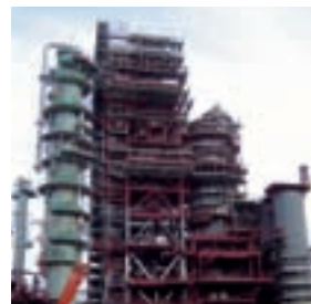
現在建設中のNo.2 FCC
