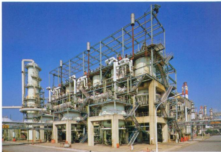
袖ヶ浦製油所 ユリカ熱分解装置
