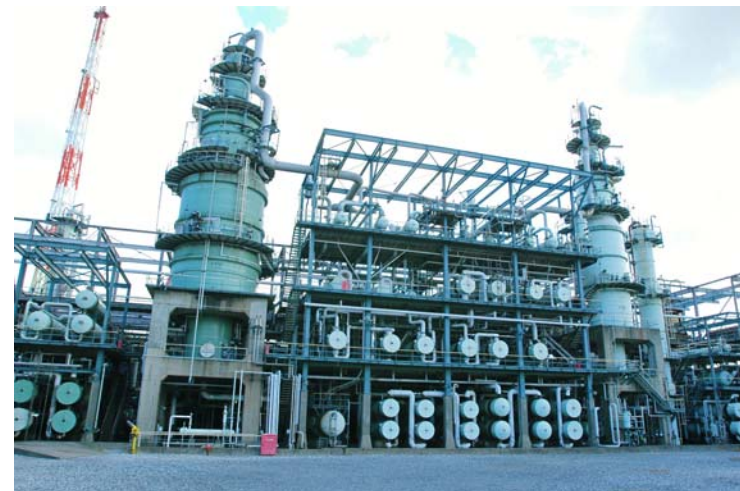
袖ヶ浦製油所 減圧蒸留装置
