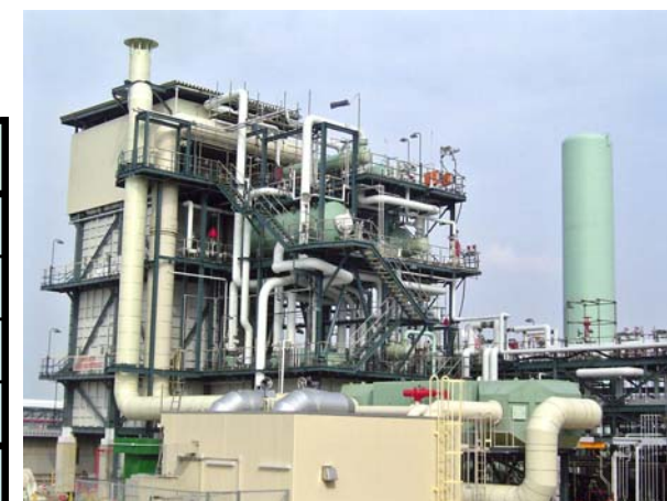
建設中の水素製造装置
