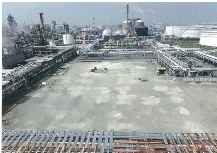
平成27年5月8日撮影(ASP-BTG建設工事全景)
