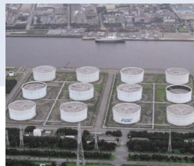
原油タンクは袖ヶ浦製油所に15基、中袖基地に12基あり、輸入された原油が搬入・貯蔵されます。なお、緊急時に備え70日分の原油や石油製品の備蓄が義務付けられています。
