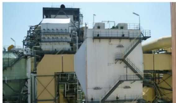
10号ボイラー発電所の乾式電気集塵機
