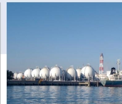
袖ヶ浦製油所には、大小さまざまな貯蔵タンクがあり、ガソリン、灯油、LPGなど、生産された石油製品は種類ごとに貯蔵され、安全に管理されています。
