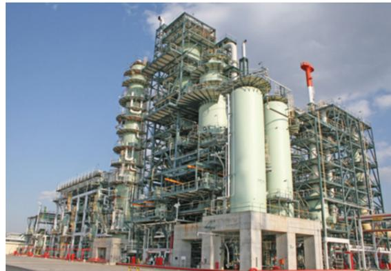
流動接触分解装置(FCC装置)
