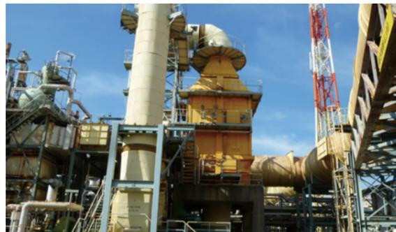
COボイラー排煙脱硝装置
