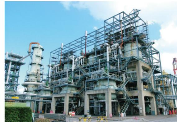
減圧残油熱分解装置(ユリカ装置)
