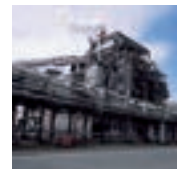
アスファルトピッチ焼きボイラータービン発電設備（ASP-BTG）
