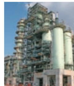
第2流動接触分解装置
