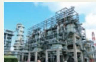
減圧残油熱分解装置
