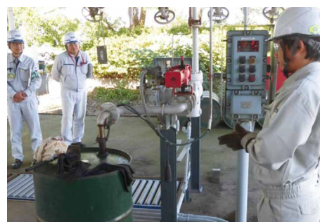
ドラム缶出荷設備取扱い訓練
