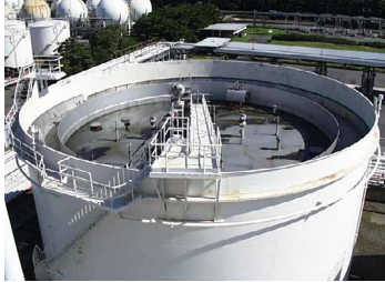
浮屋根式ガソリンタンク
