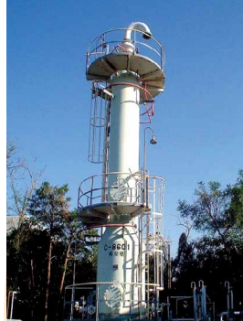
炭化水素回収装置
