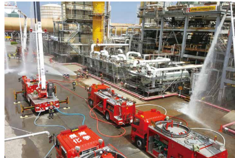
公設消防、共同防災、自衛消防車両 による一斉放水
