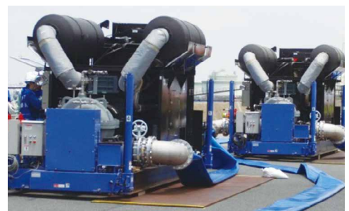
大容量泡放射システム ポンプの設置訓練
