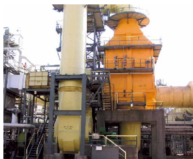
COボイラー排煙脱硝装置
