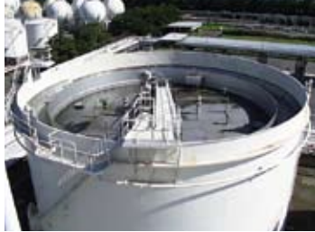
浮屋根式ガソリンタンク
