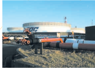
浮屋根式原油タンク
