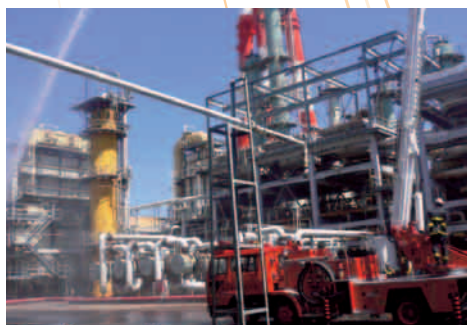
大型高所放水車の放水訓練
