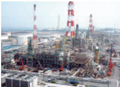
2009年度定修工事現場
