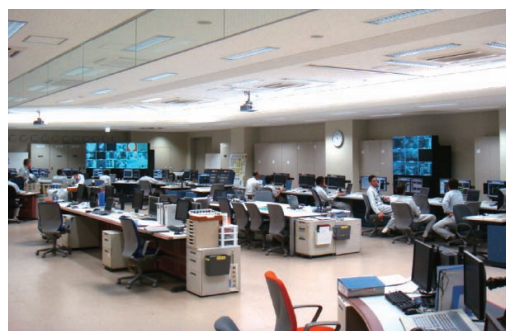
地震計に連動した装置自動停止システムを備えた統合計器室
