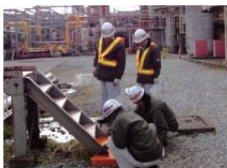
階段のペイント塗布作業
