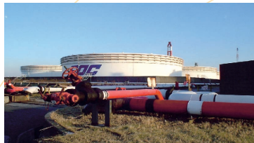
浮屋根式原油タンク
