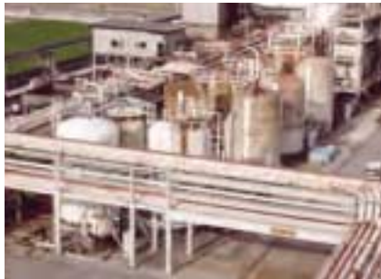
2009年6月に一部増設したろ過処理装置
