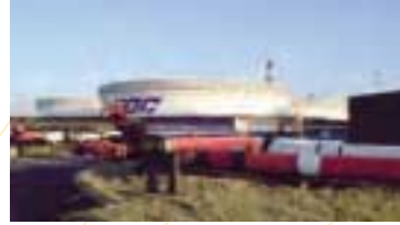
浮屋根式原油タンク
