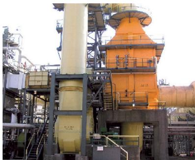
COボイラー排煙脱硝装置
