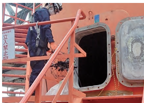
ドローンを用いた煙突内部点検 (入槽前の様子、ドローンは写真中央部の 煙突入槽口左側)
