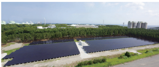
中袖基地内遊休地を利用した太陽光発電事業 (2014年6月竣工・送電開始)
