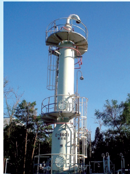
炭化水素回収装置
