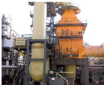
COボイラー排煙脱硝装置
