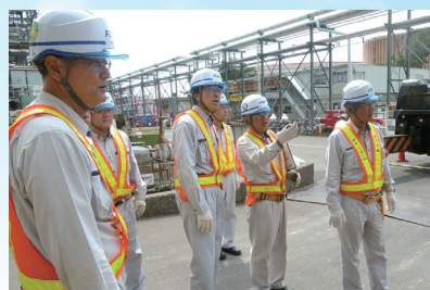
定期修理工事現場の巡視
