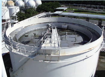
浮屋根式ガソリンタンク
