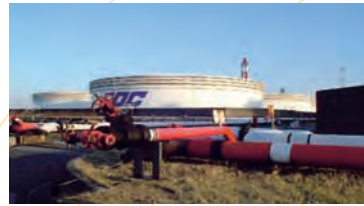
浮屋根式原油タンク
