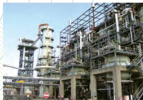
減圧残油熱分解装置
