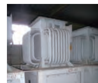
保管中の 高圧トランス
