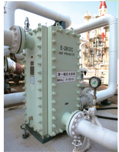
第2減圧軽油脱硫装置へ設置した熱交換器
