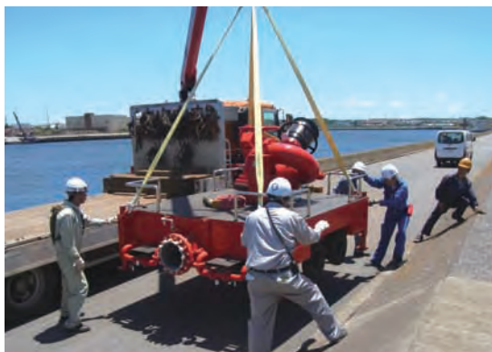
大容量泡放射砲の設置訓練
