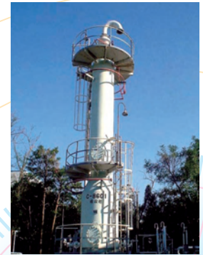
炭化水素回収装置
