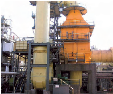
COボイラー排煙脱硝装置
