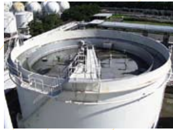
浮屋根式ガソリンタンク
