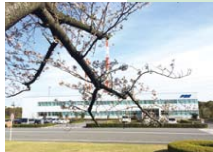
新事務棟周辺の緑化状況
