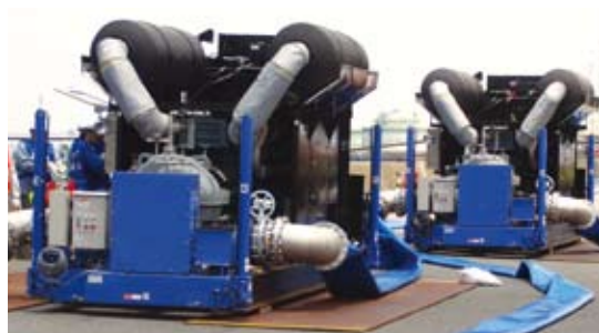
大容量泡放射システム ポンプの設置訓練
