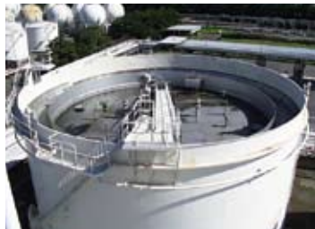
浮屋根式ガソリンタンク
