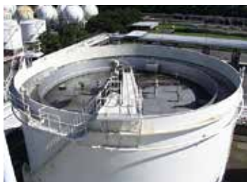
浮屋根式ガソリンタンク
