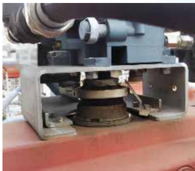
バルブ診断システムを導入しているバルブ (弁開度の偏差で不具合を事前に検知可能)
