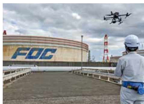
ドローンによるオフサイト点検
