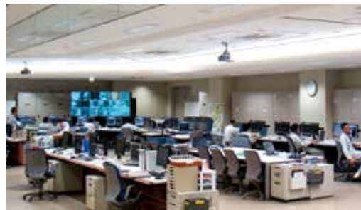
地震計に連動した装置自動停止システムを備えた統合計器室
