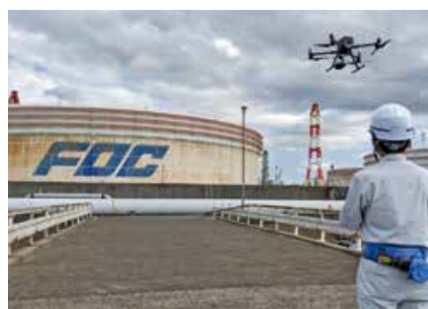
ドローンによるオフサイト点検
